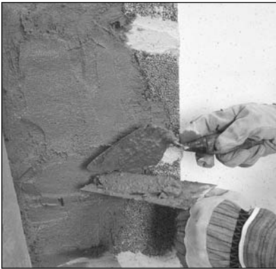
17. Putsa färdigt brandväggen och behandla ytan efter den struktur du vill ha. Genom att dra ytan med en fuktad murarborste få du en trevlig struktur, pröva dig fram. Omramningen är slammad från oss och behöver bara putsas i fogarna och kan därefter målas, gärna med en strukturfärg. Innan du målar omramningen rekommenderar vi att du täcker modulscharvorna, över frisen, med en fin glasfiberväv för att förhindra sprickbildning. Limma fast nätet med vävlim alt. fäst det i sandspackel. Om du väljer att putsa även omramningen med bruk kan du välja ett murarnät.
